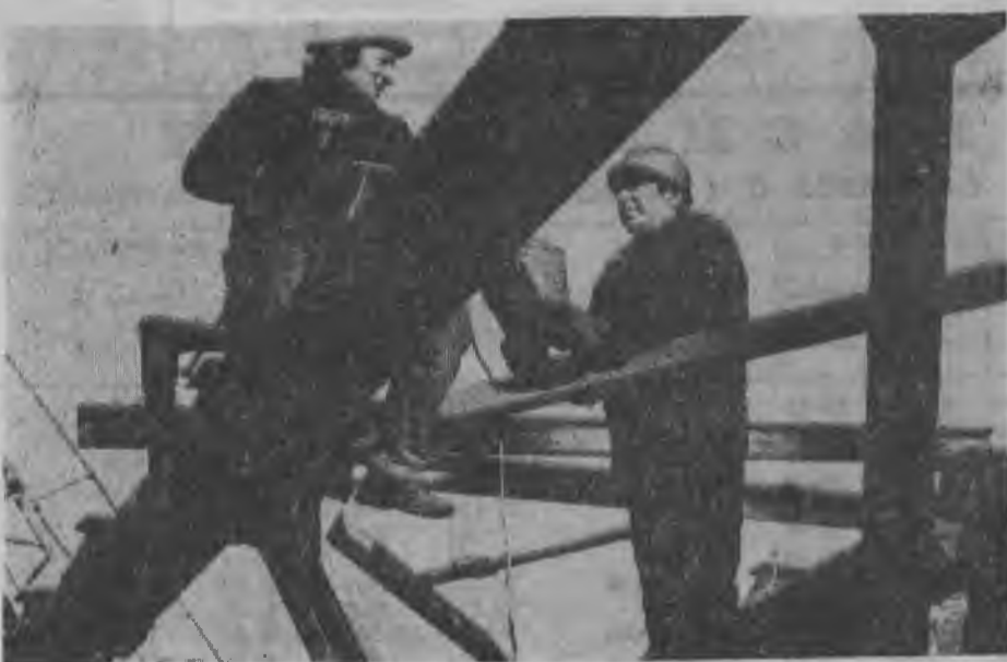
НА СНИМКЕ: монтажники В. Сачко и С. Михайлов монтируют оборудование.
