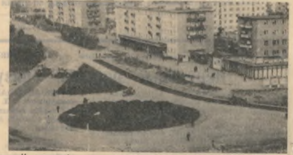
На снимке: благоустраивается перекресток улицы Строительной и Ленинградского проспекта.
