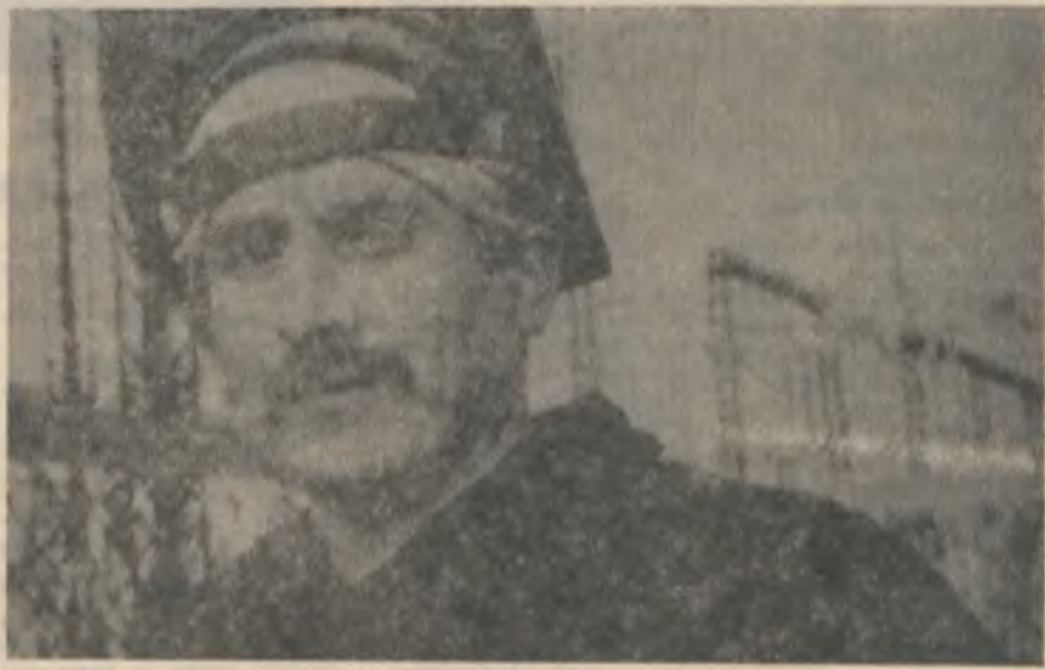
Большой вклад в строительство подстанции «Новая» — пускового объекта этого года — внесли рабочие бригады заслуженного строителя РСФСР П. И. Николаева. Хорошо трудились здесь как ветераны, так и молодежь. На снимке: молодой строитель, член передовой бригады Александр Чирков. Фото А. ГЕРГЕЛЯ.
