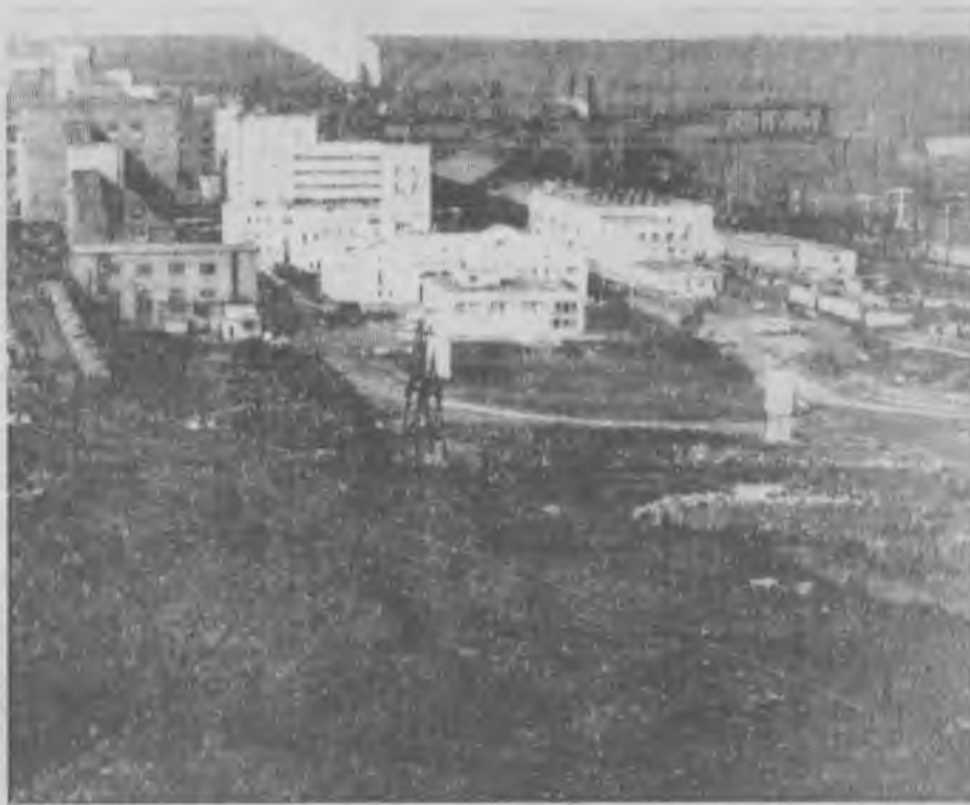
На промплощадке комбината.
