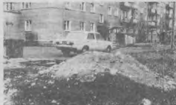
Битый кирпич, обломки асфальта, камни и трубы встанут в землю тут, между домами № 10 и 12 по ул. Космонавтов.
